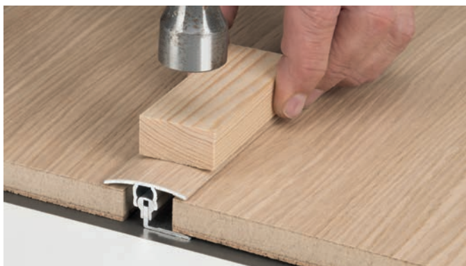
Instalace přechodového profilu hliníkového
